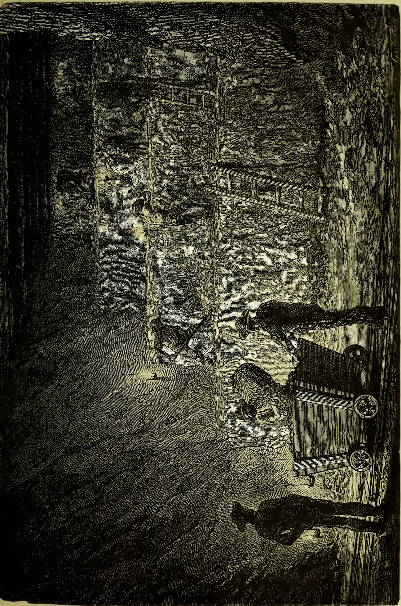
Fig. 109. — Travail en gradins droits à Stahlberg (Prusse rhénane).
